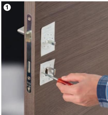
1 Schablone mit Hilfe des eingesteckten Schlüssels anbringen und Position der Führungsbohrungen auf dem Türblatt markieren
