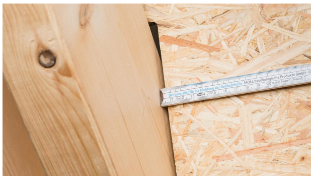
3. Controllare la larghezza delle fughe
