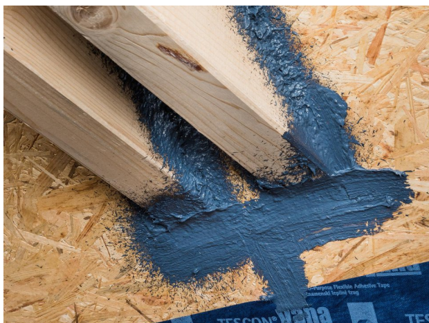
9. Raccordo su passaggio trave terminato
