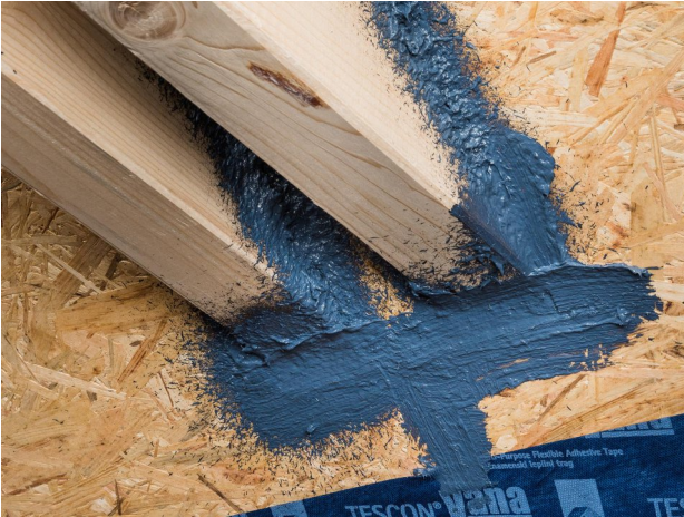
9. Fertig angeschlossene Zangendurchdringung
