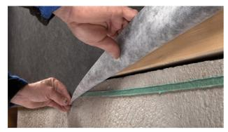
6. Alternative : Raccord à des supports rugueux ou minéraux exemple : dalle béton) avec ORCON MULTIBOND
