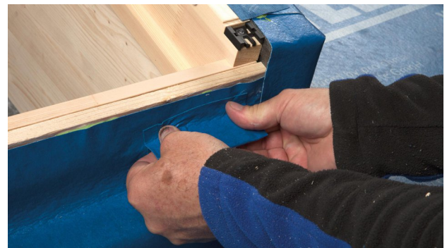
32. Montagewinkel einschweißen.
