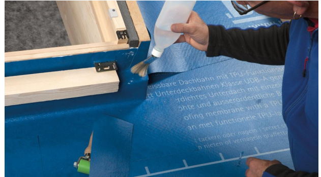
12. Passtück im Eckbereich an die Unterkante des Fensterrahmens/ Dämmrahmens aufschweissen.
