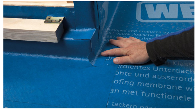
28. Auf wasserführende Bahnenüberlappung achten.
