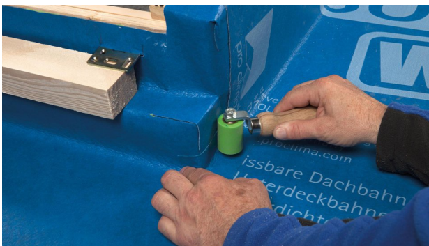
29. SOLITEX WELDANO Streifen anschweißen.
