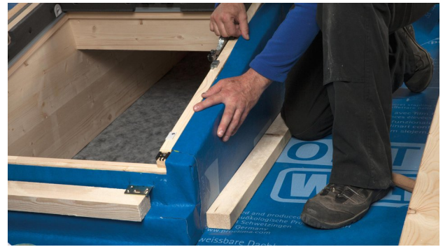
22. SOLITEX WELDANO entlang der Rahmenkante verkleben. Bahn mit Dehnschlaufe in das Kleberbett legen. Kleber dabei nicht ganz flach drücken, damit ggf. Bewegungen aufgenommen werden können.
