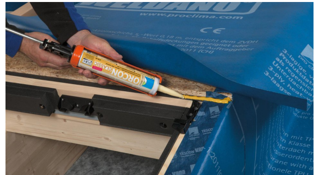
24. Flächige SOLITEX WELDANO mit ORCON CLASSIC am oberen Fensterrahmen verkleben.
