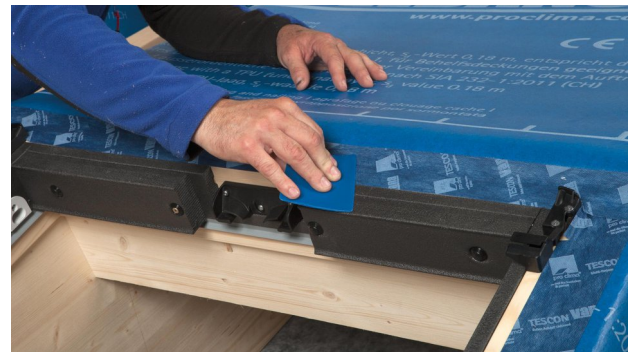
26. TESCO VANA zur praktischen Montage-Fixierung verwenden.
