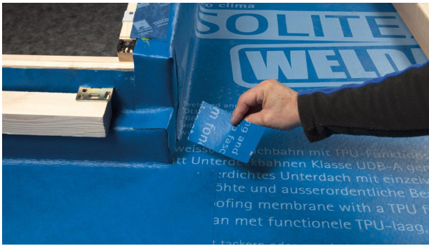
27. Um Schnittkanten im unteren Eckbereich zu überdecken, einen kleinen Streifen SOLITEX WELDANO ausschneiden und anlegen.
