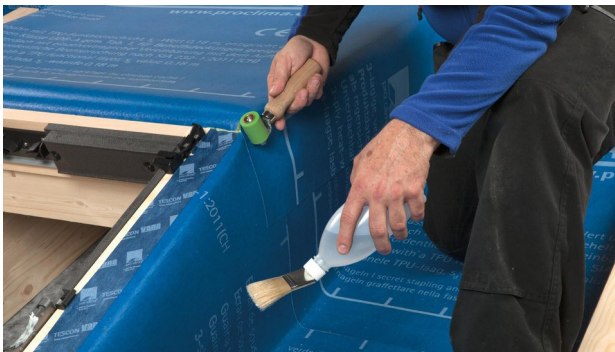
25. Seitlich die Lagen SOLITEX WELDANO miteinander verschweissen.
