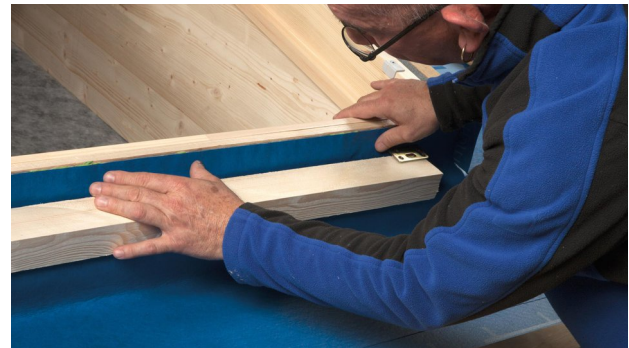
8. SOLITEX WELDANO-S mit Dehnschleife in das Kleberbett legen. Kleber dabei nicht ganz flach drücken, damit ggf. Bewegungen aufgenommen werden können.
