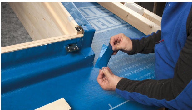
31. Hilfs-Tragplatte entfernen und Passstücke zum einkleben der Montagewinkel zuschneiden.
