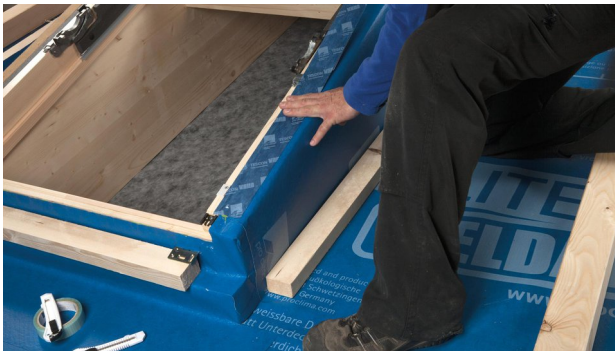
23. TESCO VANA zur praktischen Montage-Fixierung verwenden.
