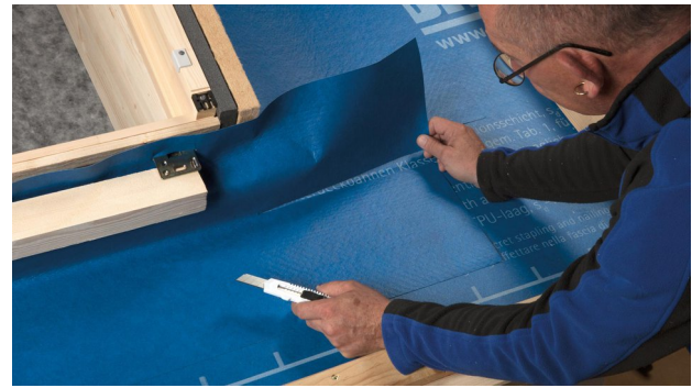
4. Horizontalschnitt bis Aussenkante des Fensterrahmens/Dämmrahmens.
