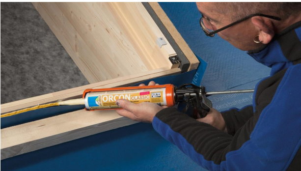
7. ORCON CLASSIC Raupe mit mind. 6 mm Durchmesser auf mineralischen Untergrund auftragen (bei rauen Untergründen ggf. mehr) und SOLITEX WELDANO-S an der Unterseite des Fensterrahmens ankleben.
