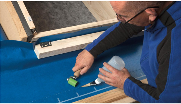
3. SOLITEX WELDANO-S an der Unterkante auf der flächigen SOLITEX WELDANO-S faltenfrei verschweissen (mit Quellschweissmittel oder Heissluftgerät).
