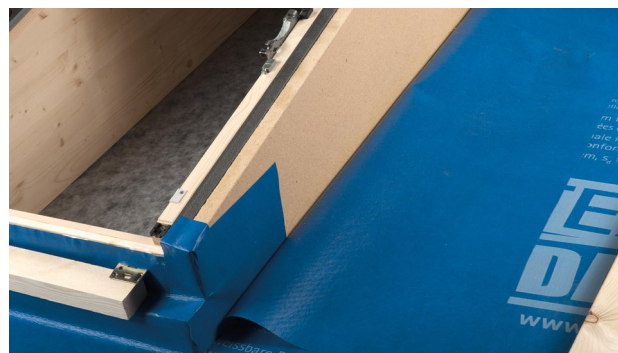
16. L'étanchéité terminée au niveau des coins inférieurs
