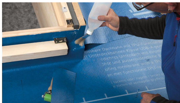
12. Souder le bout confectionné dans les coins, sur le bord inférieur du châssis de fenêtre / cadre d'isolation thermique.
