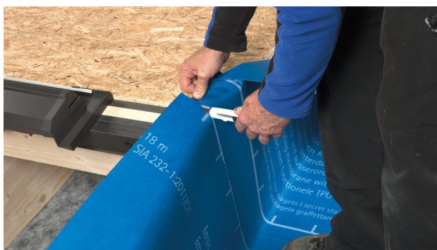
17. Faire remonter l'écran de la surface plane sur les flancs de la sous-costière. Alternative : couper à dimension un autre bout d'écran SOLITEX WELDANO-S, le remonter sur la sous-costière et le souder en bas sur l'écran posé à plat.
