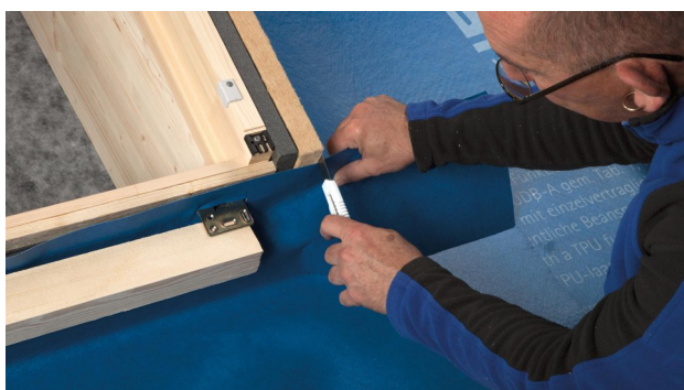
5. Couper l'écran à la verticale le long du bord extérieur du châssis de fenêtre / cadre d'isolation thermique jusqu'au bord inférieur de la latte.
