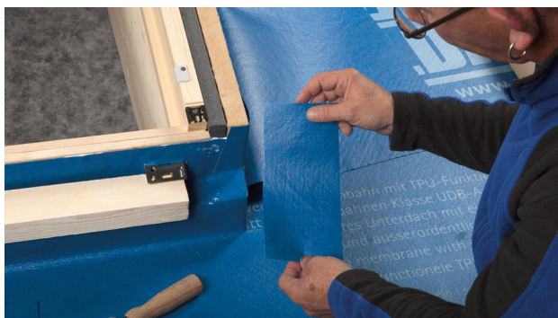
11. Couper à dimension un bout d'écran qui recouvrira les entailles dans la zone châssis-coins. Sa longueur sera d'env. 15 à 20 cm et sa largeur d'env. 10 à 12 cm.
