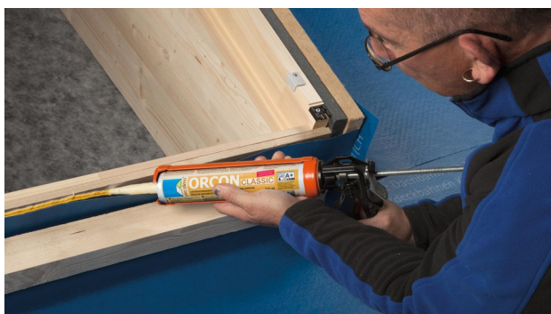
7. Appliquer un cordon de colle ORCON CLASSIC d'au moins 6 mm de diamètre sur le support minéral (le cas échéant, davantage sur des supports rugueux) et coller SOLITEX WELDANO-S sur la partie inférieure du châssis de fenêtre.
