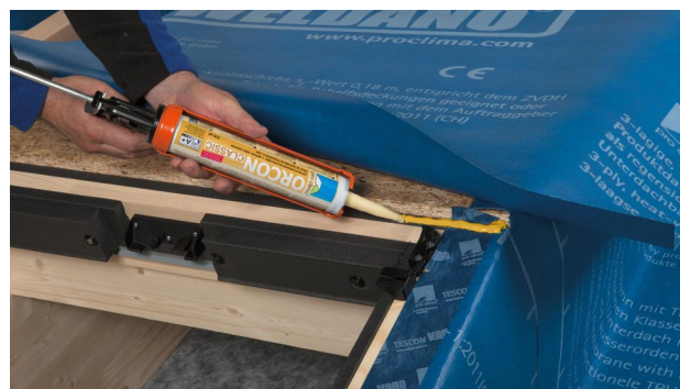
24. Coller l'écran SOLITEX WELDANO posé à plat sur le châssis de fenêtre supérieur, avec ORCON CLASSIC.
