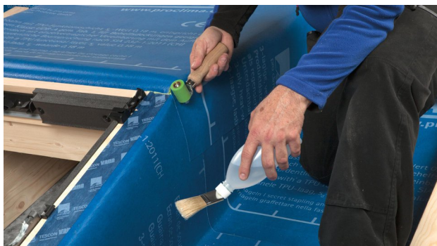
25. Souder les couches de SOLITEX WELDANO entre elles, sur le côté.
