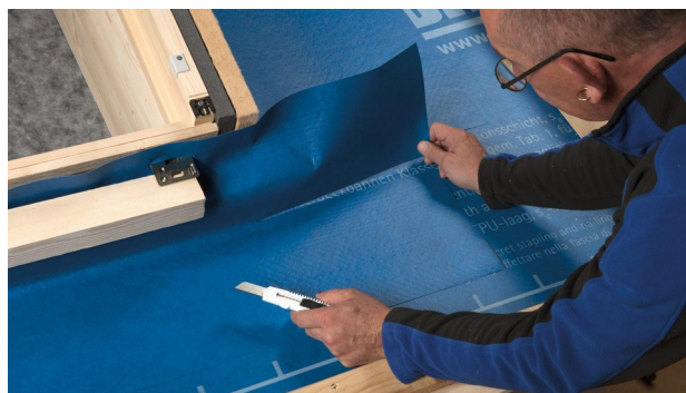
4. Couper l'écran à l'horizontale jusqu'au bord extérieur du châssis de fenêtre / cadre d'isolation thermique.
