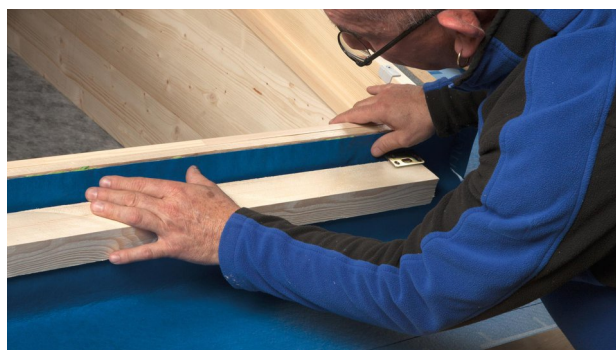
8. Poser SOLITEX WELDANO-S avec une boucle de dilatation dans le lit de colle. Ne pas aplatir complètement la colle, afin de permettre une compensation des mouvements de l'ouvrage.
