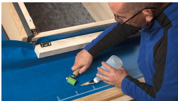
3. Souder SOLITEX WELDANO-S sans plis sur la face inférieure de la partie plate de l'écran (avec un produit de soudage par solvant ou un appareil à air chaud).
