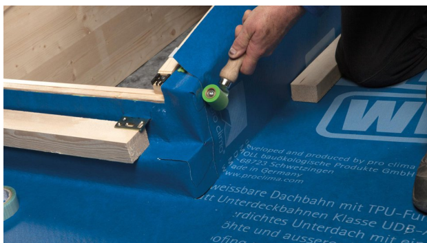
21. Maroufler l'assemblage par soudage (par exemple avec le rouleau en silicone pro clima ROLLFIX).
