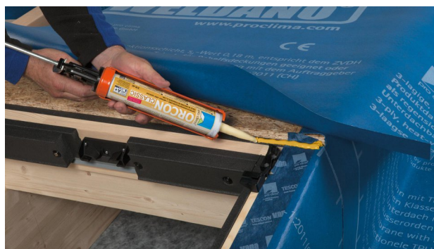
24. Coller l'écran SOLITEX WELDANO posé à plat sur le châssis de fenêtre supérieur, avec ORCON CLASSIC.
