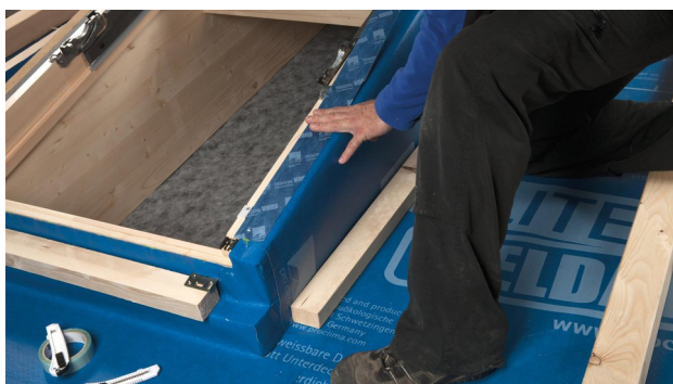
23. Utiliser TESCON VANA pour faciliter le montage et la fixation.
