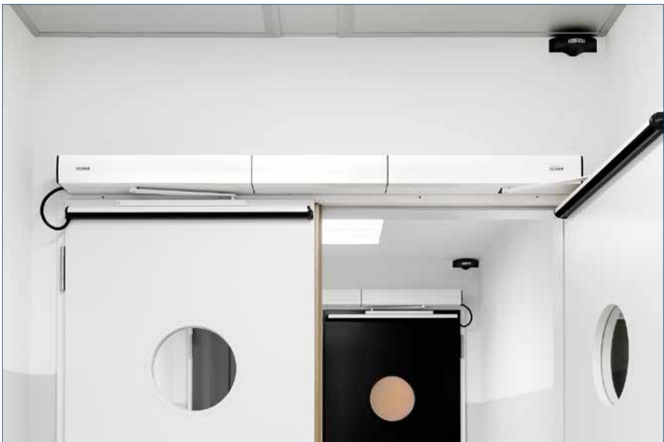
TSA 160 NT Z-IS et détecteurs de mouvements à radar GC 302, Andels Hotel, Berlin, Allemagne (photo : Stefan Dauth)
