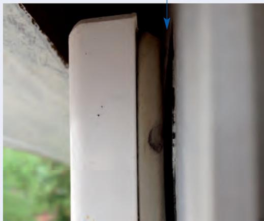
Posizione di montaggio in porte sinistre sopra alla serratura
