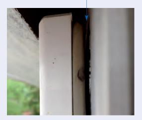
Pos. de montage sur les portes montées à gauche au-dessus de la serrure de la porte.
