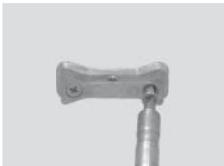
Wandanschluss-Innenteil an der Decke anschrauben
