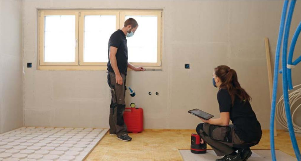
Erfassen von allen Details mit dem Leica 3D Disto
